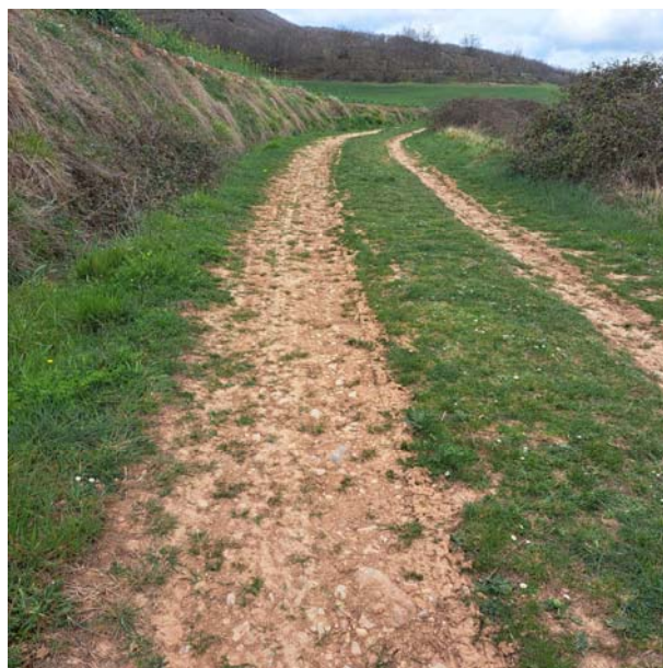
FOTO 8 CAMINO DE ACCESO.
